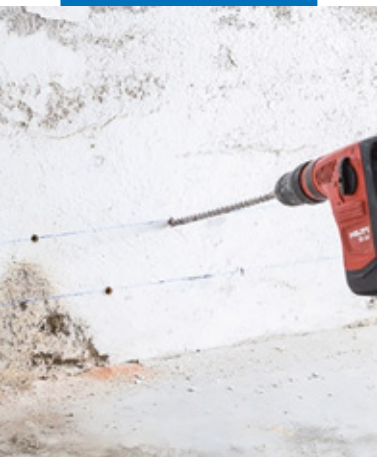
Realizzazione dei fori
